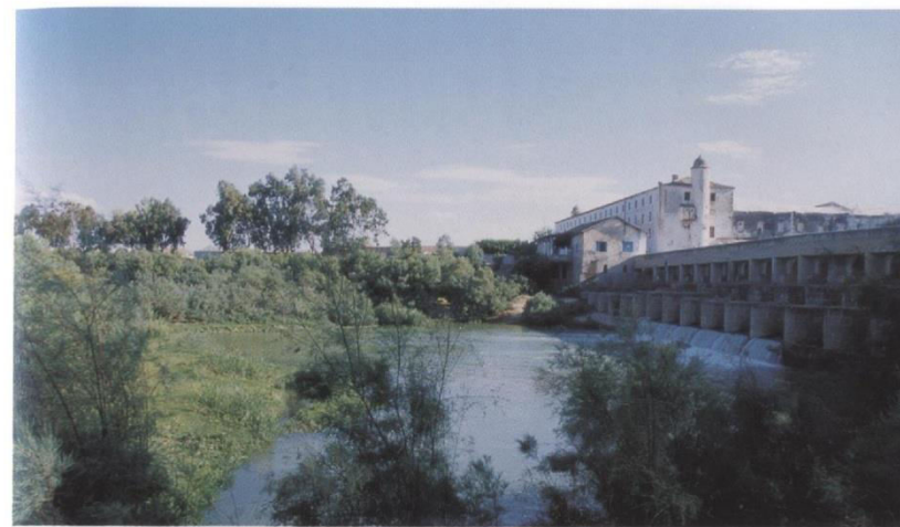
Pont-barrage d'el-Battan, Tébourba.
