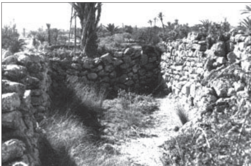
Fig. 5: Moellon de la croûte calcaire de Kerkéna.
