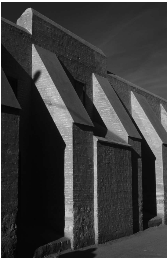
Fig. 6 : Murs à contreforts de la mosquée Zaytūna de Kairouan.
